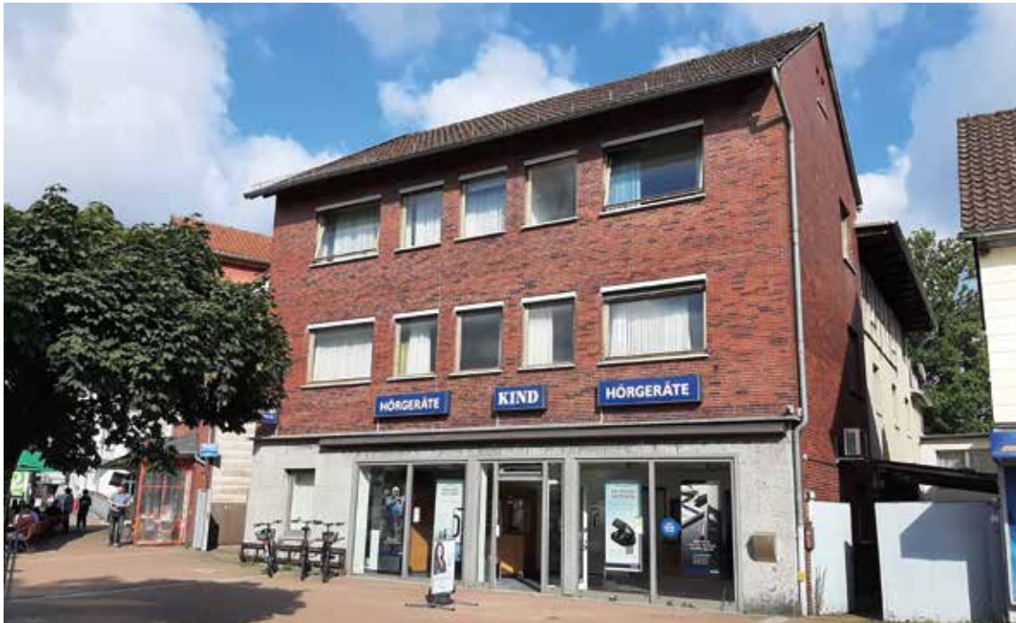
Abb. 30: Das Gebäude der ehemaligen Schlachtereier Müller heute.
