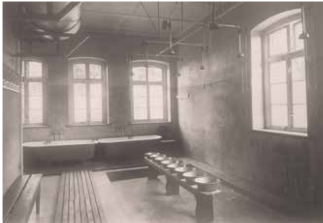
Abb. 13: Waschraum in der Arbeiterkolonie um 1931.
