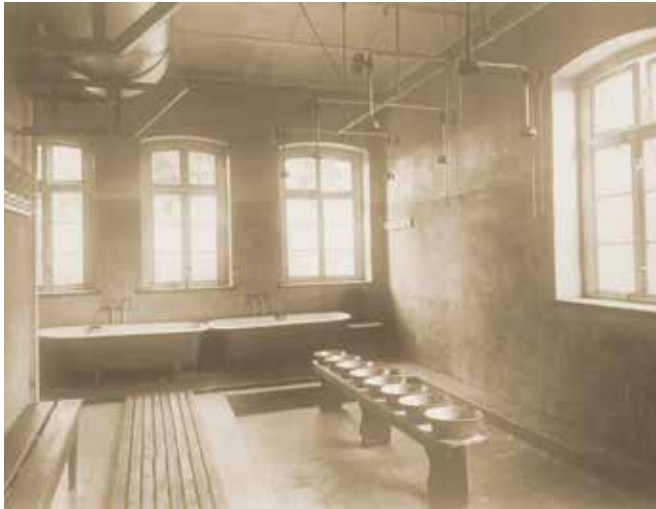
Abb. 28: Waschraum in der Arbeiterkolonie um 1931
