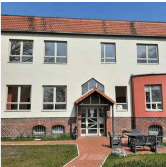
Abb. 40: Das Erziehungsheim Rischborn wurde 1966/67 umgebaut. Das Haus ist bis heute Teil der Kästorfer Jugendhilfe
