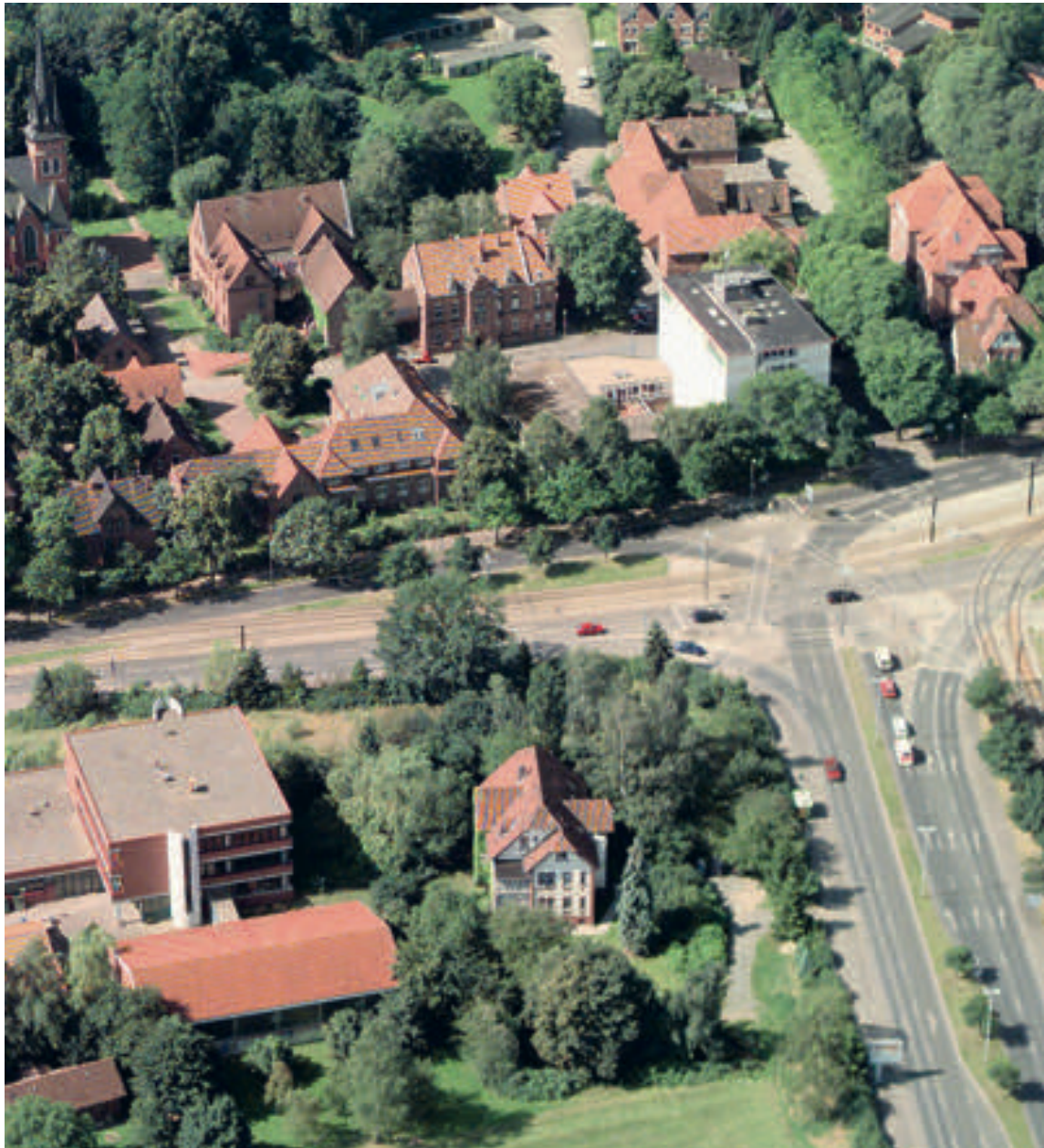
Blick auf das Stephansstift, 2003. Am oberen Rand ist die Stiftskirche zu sehen, darunter das 1884 eingeweihte Ensemble des alten Knabenhofs. Im Uhrzeigersinn: Lemmermannhaus und Haupthaus, davor das alte Brüderhaus. Rechts hinter dem Haupthaus die alte Wäscherei und das Wasserwerk, daneben der sog. und inzwischen abgerissene Schelperbau, davor das Wichernhaus (weiß); am Rand rechts außen das Lehrlingsheim. Unten rechts, auf der anderen Straßenseite, das Haus Freienfelde, links davon das Diakonie-Kolleg, ehemals Fachschule für Sozialpädagogik, daneben das Gelände des Berufsbildungszentrums mit Werkhallen. Auf der anderen Straße links neben dem Spielplatz der Knabenhof mit Sporthalle, daneben das Gebäude der Ludolf-Wilhelm-Fricke-Schule, rechts darüber das Paul-Friedrich-Mau-Haus und daneben das Freytaghaus.
